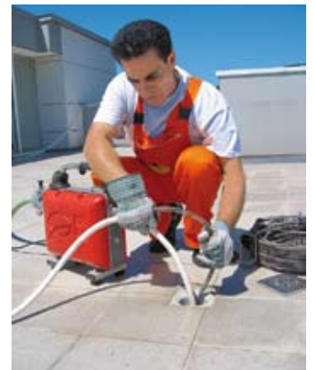
Aufbohren eines Terrassenablaufs: Immer mehr Deutsche schwören auf den Service von RohrMax.
