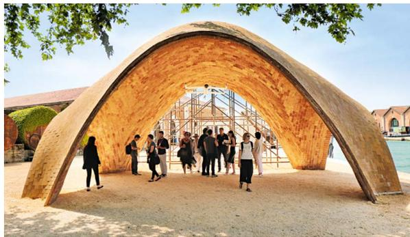
Der Droneport von Lord Norman Foster besteht aus Durabrick; das LafargeHolcim Research Center hat den Baustoff für diesen Aufsehen erregenden Prototyp modifiziert
